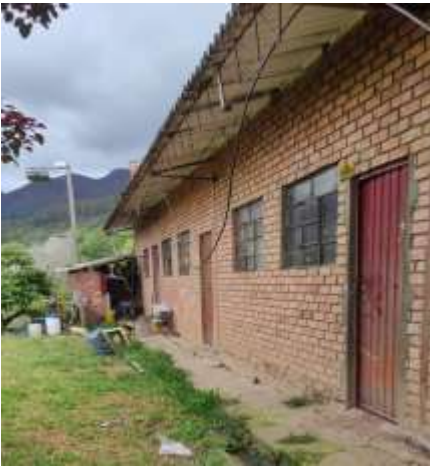
Ilustración 11. Cuarto aseo y almacenamiento
