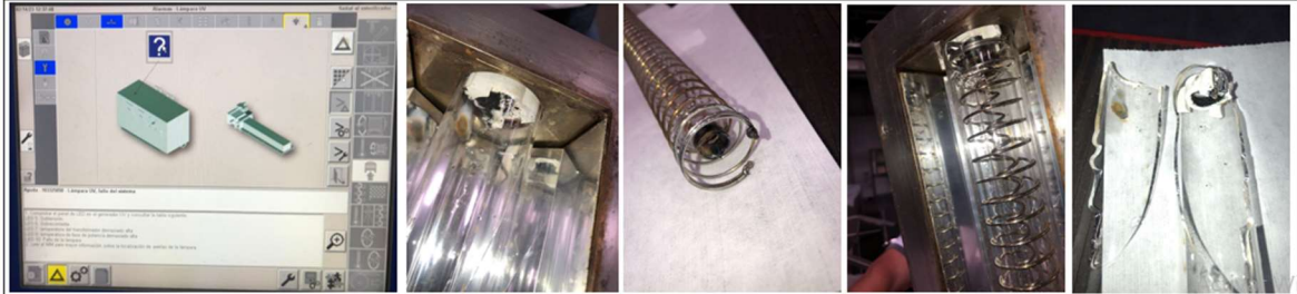
Ilustración 24. Antecedentes de falla, evidencia fotografica
