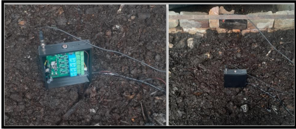
Ilustración 57. Instalación de sistema de control en etapa final.
