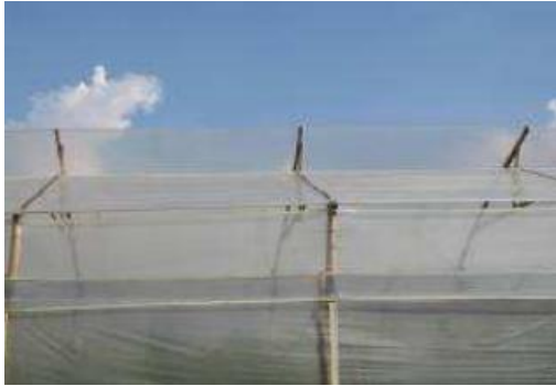
Figura 21 Invernadero con apertura fija en la cumbrera
