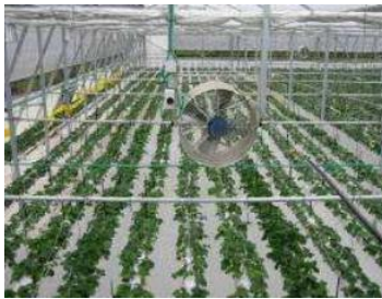
Figura 22 Ventilador para la liberación de calor en invernaderos climatizados
