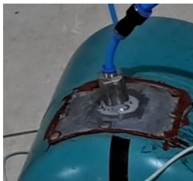
Ilustración 41. Sellado con silicona de alta temperatura y tornillos autoperforantes.
