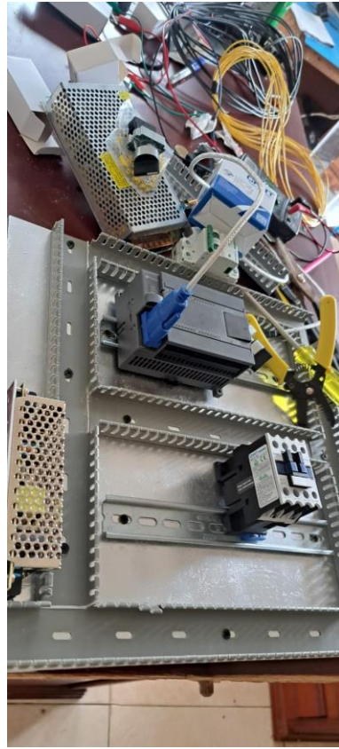
Ilustración 568. Construcción tablero eléctrico.
