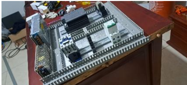
Ilustración 57. Avance construcción, instalación de elementos eléctricos.
