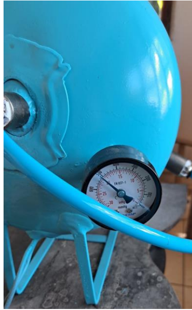
Ilustración 79. Generamos el vacío adecuado al sistema.
