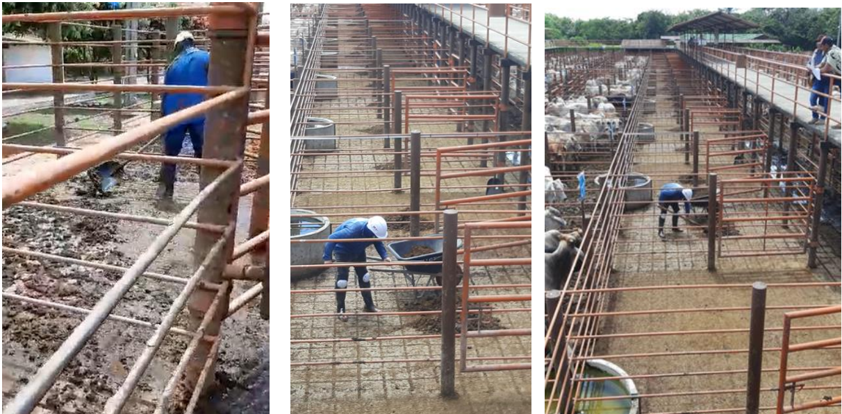
Figura 24. Remoción de materia orgánica y limpieza del piso SUBACASANARE
