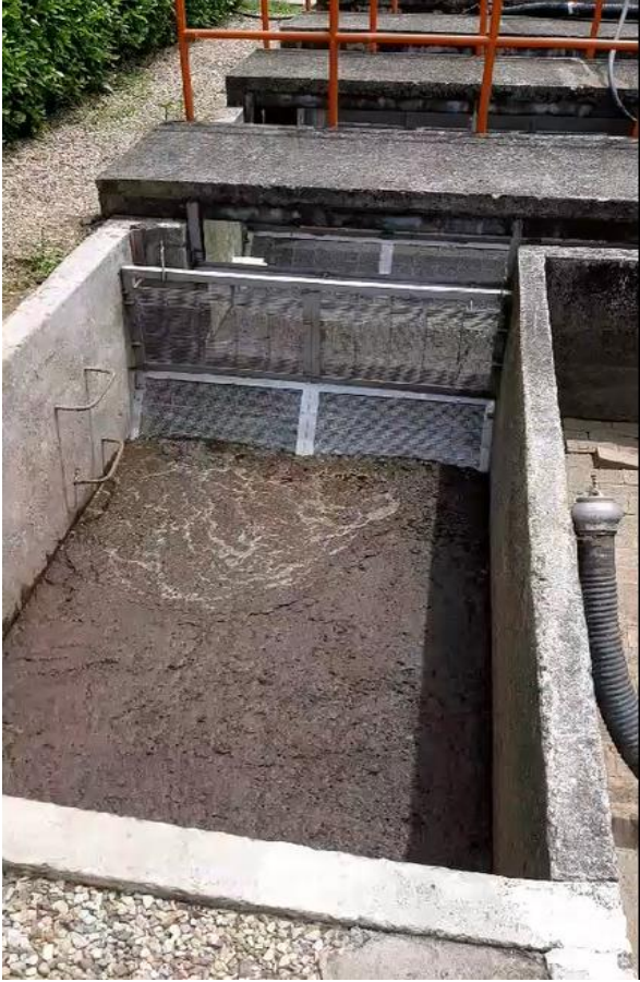
Figura 13. Subasta Ganadera de Yopal. Pozo de oxidación
