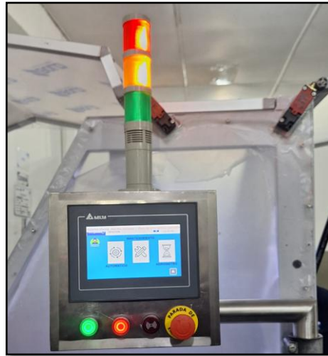
Figura 16. Ventana Principal Pantalla HMI
