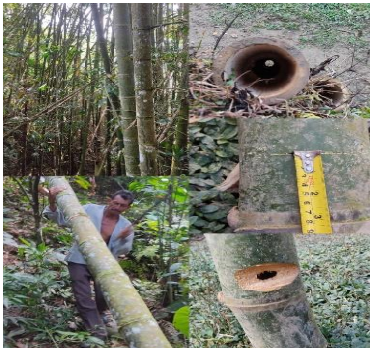
figura 6 Selección corte des-canutado y agujereado de guadua para la parte estructural. Propia.
