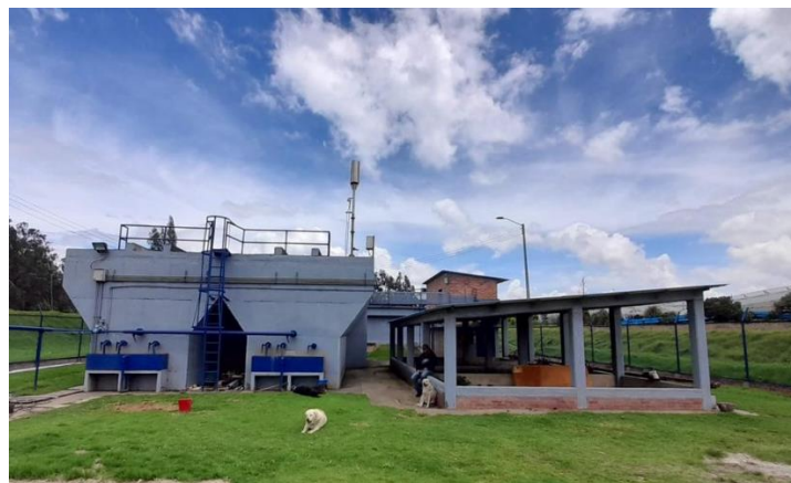
Planta de tratamiento de aguas residuales número 2 del municipio de Sesquilé Cundinamarca. Fuente: elaboración propia
