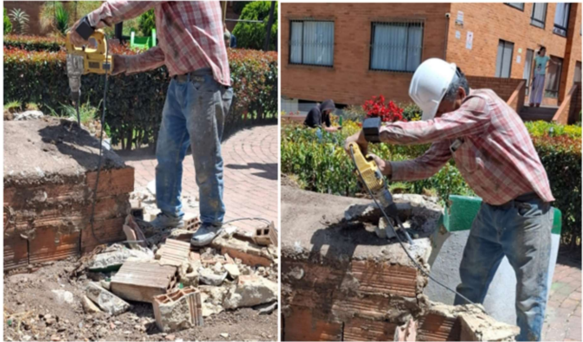
Figura 57 Prueba piloto 1 – Sector de construcción
