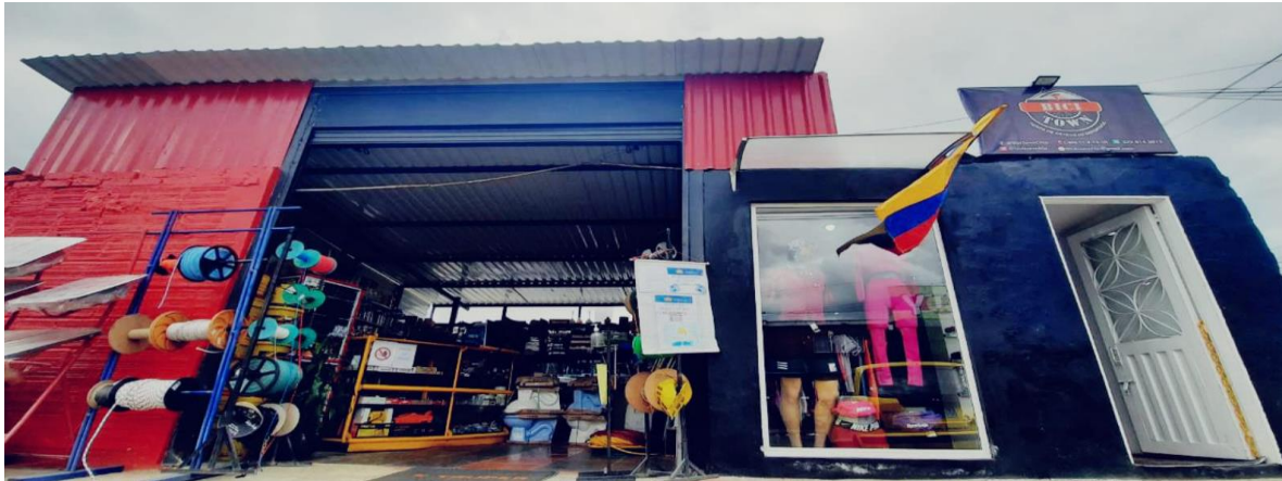
Figura 10 Después de Modificación de infraestructura en Vethel Ferretería Chía
