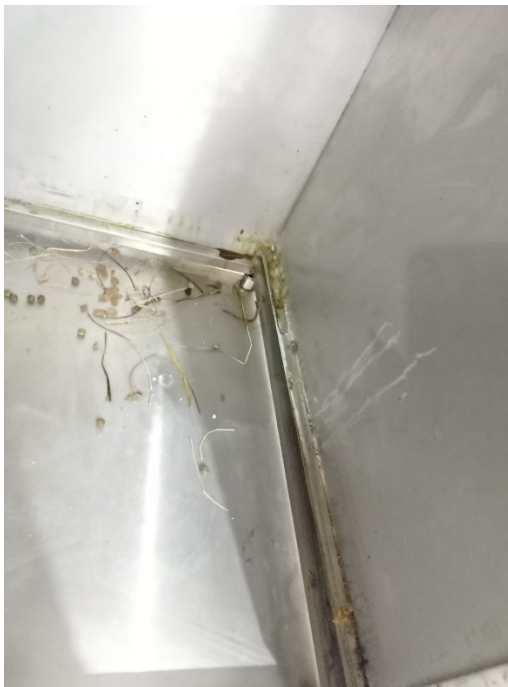
[Figura 8] de Autores (Pet Company, 2022) Colombia, Bogotá. Jaulas funcionales como área de hospitalización en la cual las hendijas de las bandejas primaria y secundaria no se limpiaban con la frecuencia necesaria por tanto permanecían por varios días con restos de materia fecal, orina y emesis.
