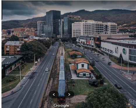
Figura 5. Estación de tren Localidad de Usaquén.
