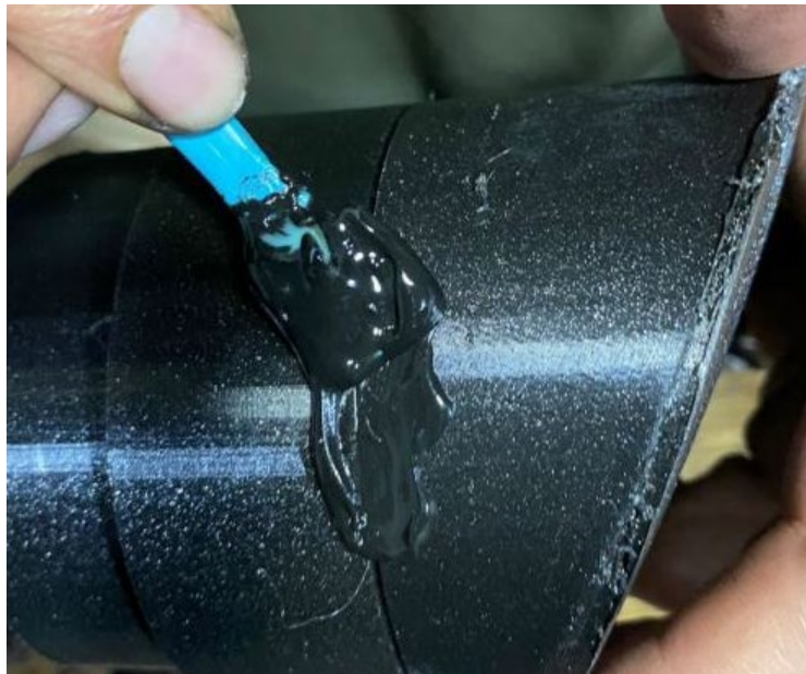
Figura 98. Aplicación de soldadura en frío en tapón de casco.
