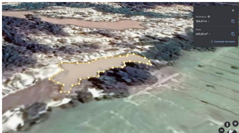
Figura 107. Área superficial de laguna.
